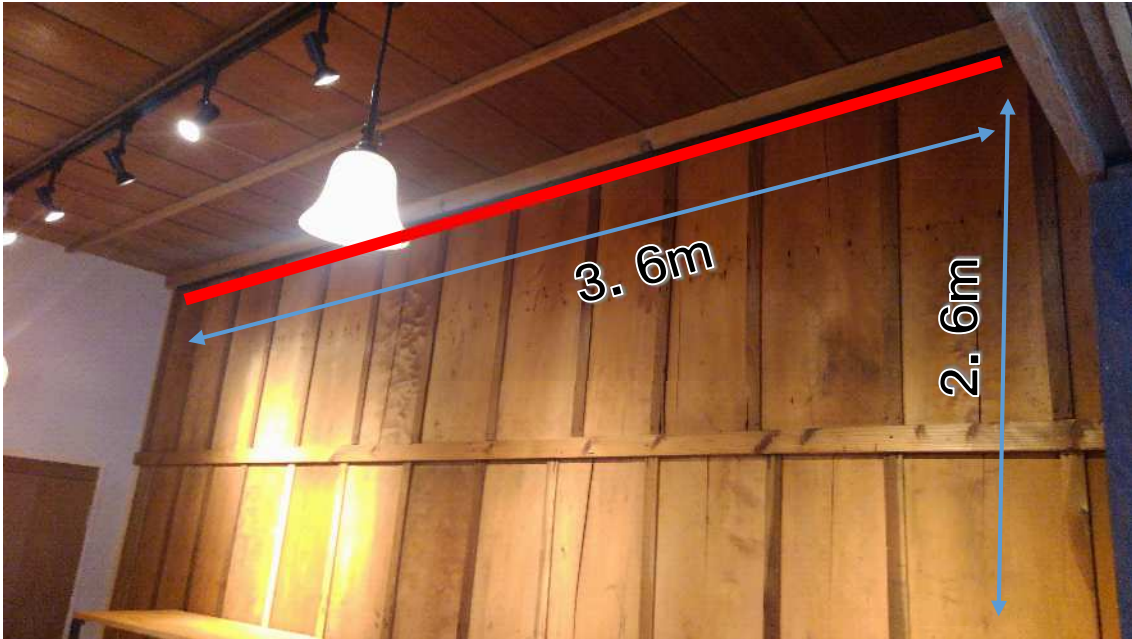
① 入って右の壁面 天井付け用金物使用 掲示範囲 横 3.6m、高さ床より 2.6m (ワイヤー長さ1mと1.5m)
